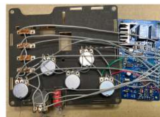
配線作業の様子
